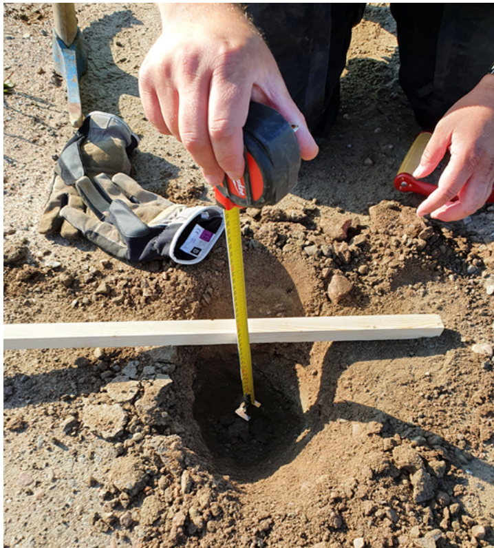
Figur 3. Mätning av överbyggnadens tjocklek.
